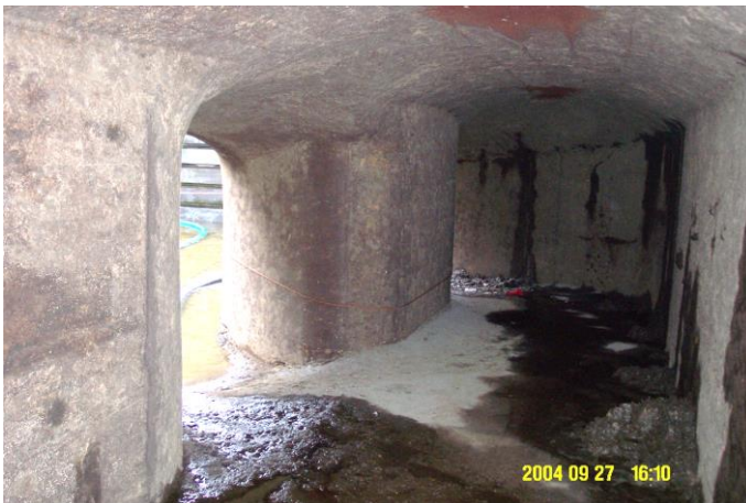
Omloopriolen sluis Halle
