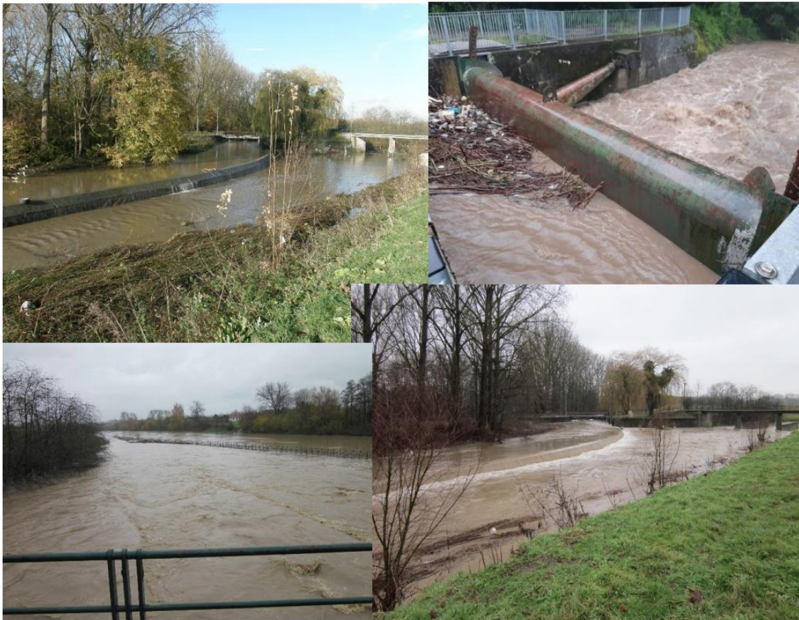
Figuur 6: foto's van de radiaalschuif (stuw) te Lembeek bij hoge debieten, met werking van de schuif en overlaat.
